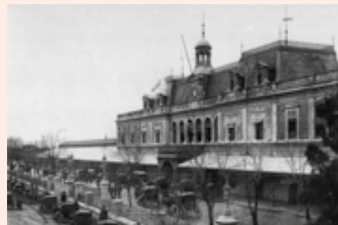
Estación de la Compañía Francesa de Ferrocarril de Santa Fe, avenida Santa Fé y Cafferata, Rosario, provincia de Santa Fe (1885). Demolida en 1962. Fuente: CEDODAL.
