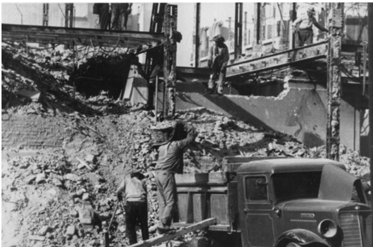
Proceso de demolición calle Cerrito y Corrientes, Buenos Aires, 1936.
