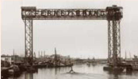
Puente Transbordador "Luis Sáenz Peña", Garibaldi y Don Pedro de Mendoza, Buenos Aires (1913). Desmantelado en 1965. Fuente: AGN.
