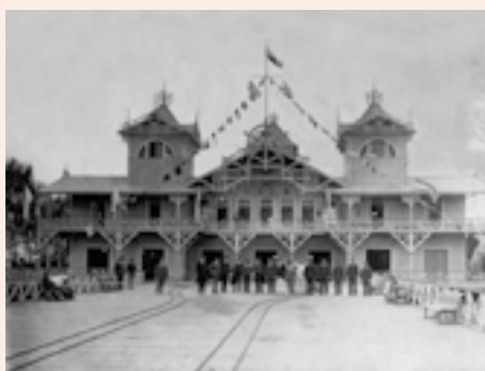
Club de Regatas "La Marina" (1907), Río Luján frente a la estación fluvial de Tigre. Demolido en 1927 y reemplazado por el actual.
