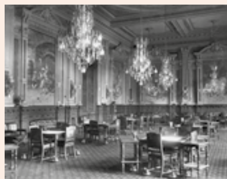
Jockey Club, Florida entre Lavalle y Tucumán, Buenos Aires (1897, Ing. Emilio Agrelo). Incendiado en 1953 y posterior demolición. Fuente: CeDiap.
