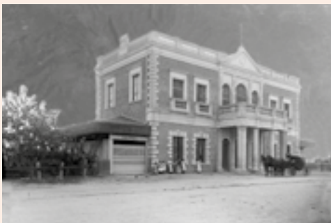
Estación "Alta Córdoba", Ferrocarril Córdoba Noroeste, Rodríguez Peña 1800, Alta Córdoba, provincia de Córdoba (1892). Demolida 1960. Fuente: AGN.
