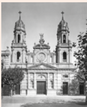
Catedral de Avellaneda (provincia de Buenos Aires), demolida en 1971. Fuente: AGN.
