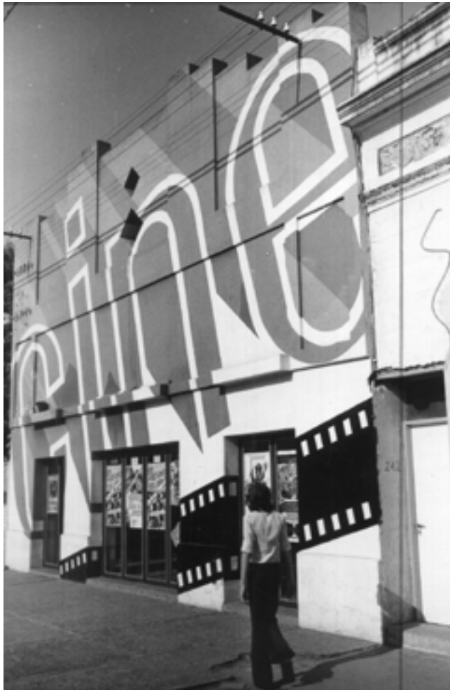
Sala de cine Biógrafo, Güemes 250, Resistencia, provincia de Chaco. Transformación funcional en comercio hacia 1971.
