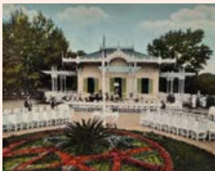
Club "Crisol" (1914). Demolido en 1939. Fuente: CEDODAL.
