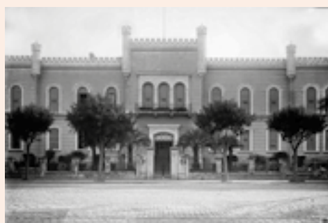
Residencia del Director de la Penitenciaría, ingreso por avenida Las Heras (1877, Arq. Ernesto Bunge).
