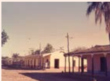
Calle del pueblo de Saladas, provincia de Corrientes, siglo XIX. Parcialmente demolida. Foto: Roberto Bonifacio, 1970.
