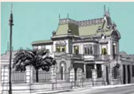
Palacete Nicolás Pagano (Arq. Coni Molina, 1911), Alsina 319, Bahía Blanca (provincia de Buenos Aires), demolido en 1984.
