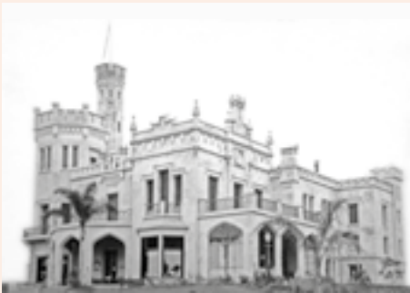
Castillo "Villa Ombúes" de Ernesto Tornquist (Arq. Carlos Nordmann, 1872), predio en avenida Luis María Campos, Villanueva, Gorostiaga y Olleros, Buenos Aires, demolido en 1980.
