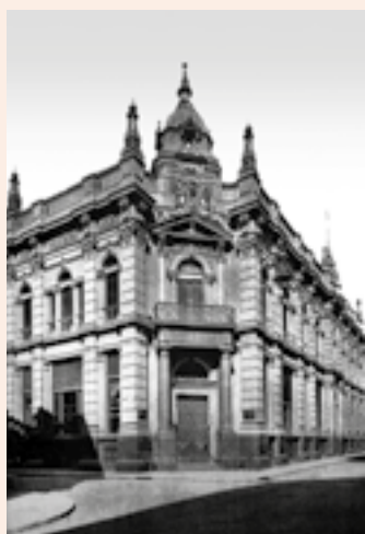
Banco Británico de América del Sud (arq. Fernando Moog, 1894), Buenos Aires, demolido para sede del Banco Nación, 1940. Fuente: Colección Museo Banco Provincia de Buenos Aires.
