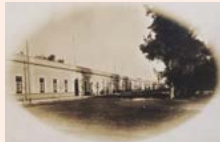
Casa de Gobierno, Plaza Independencia, Mendoza (1863-1864, Ing. Pompeyo Moneta). Demolida en la segunda mitad del siglo XX. Fuente: CEDODAL.
