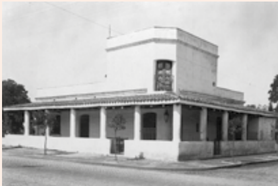
Esquina conocida como la "Posta de Pueyrredón", San Isidro (provincia de Buenos Aires), demolida en 1935 por ensanche de la Avenida Márquez. Fuente: AGN.
