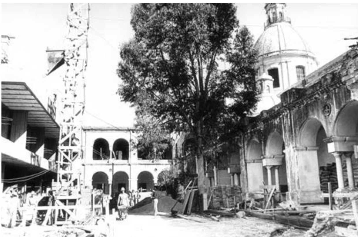
Demolición claustro Convento de Santo Domingo, Córdoba, c. 1970.
