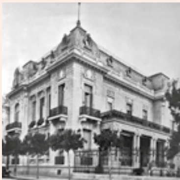
Palacio Ángela T. de Pinasco (Arqs. Bosco y Meliga, 1904), bulevar Oroño y Córdoba, Rosario (provincia de Santa Fe), demolido en 1964.
