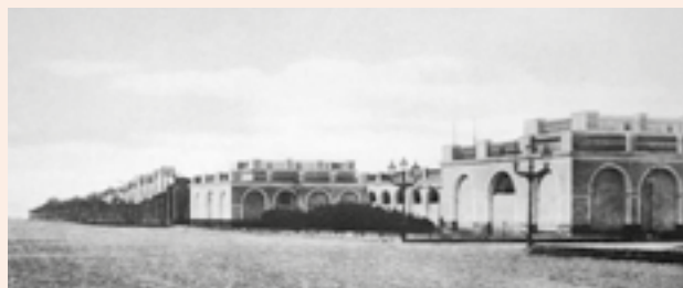
Casa Juan Manuel de Rosas, Palermo, Buenos Aires (1834, Arq. José Santos Sartorio). Demolida hacia 1880. Fuente: AGN.
