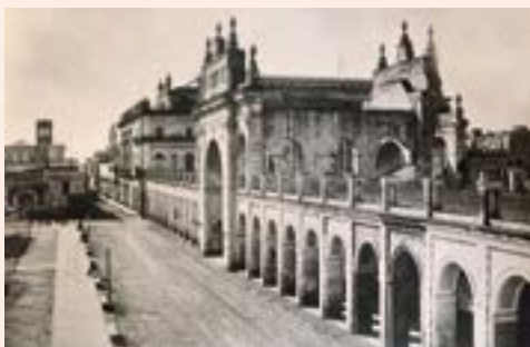
Recova, Buenos Aires (1802, Arqs. Juan B. Segismundo, Agustín Conde y Francisco Cañete). Demolida en 1883, al unificar las dos plazas.
