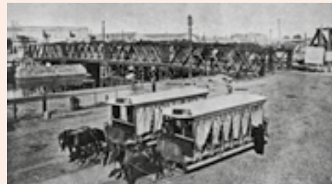
Puente "Valentin Alsina", avenida Sáenz y avenida Pedro de Mendoza, Buenos Aires (nov. 1859). Demolido en 1910. Fuente: CEDODAL.
