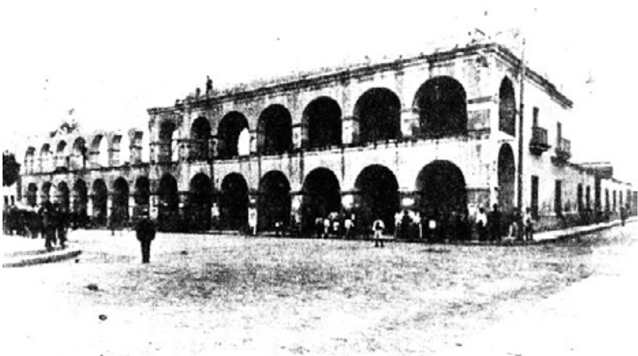
Demolición Cabildo, Tucumán, 1908.
