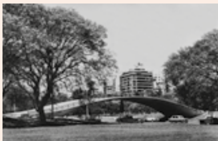
Puente para sesquicentenario de la Revolución de Mayo, altura de Gelly y Obes, monumento a Mitre y calle Libres del Sud, entre las vías y Figueroa Alcorta, Buenos Aires (1960, Arqs. Silvio Grichener y César Janello e Ing. Atilio Galoy). Demolido en 1974 y reconstruido en 1977, frente a la Facultad de Derecho. Fuente: CEDODAL.
