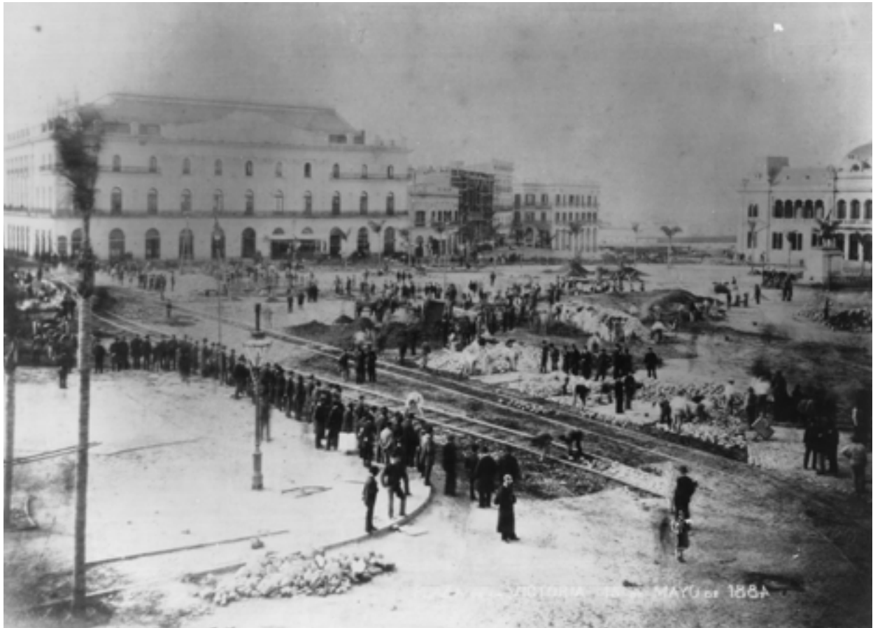
Demolición de Recova para transformación de Plaza de Mayo, Buenos Aires, 1884.
