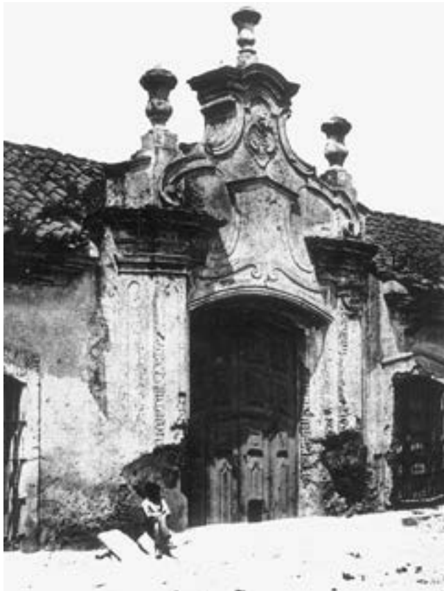
Casa de Domingo Basavilbaso, luego Aduana desde 1778, Belgrano y avenida Paseo Colón, Buenos Aires. Demolida en la primera mitad del siglo XIX.
