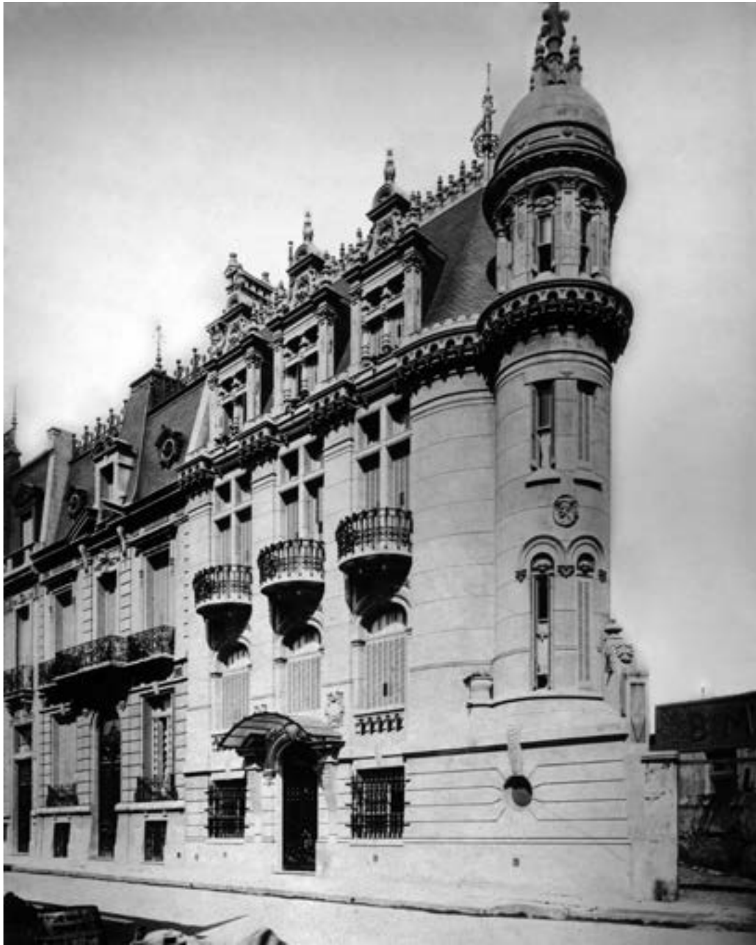
Casa Egusquiza (Arq. Le Monnier), Libertad 1394, Buenos Aires, premio a fachada por la Municipalidad de Buenos Aires en 1906. Demolida.
